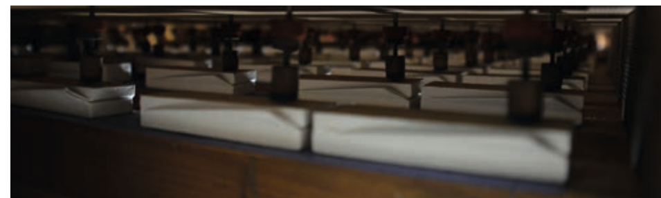
Detailansicht der erneuerten Keilbälgen unter der Windlade
